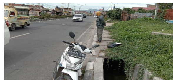
Gambar 3. Foto Saluran Drainase Jl. Jamin Ginting yang berada di sisi kiri dan kanan Jalan
